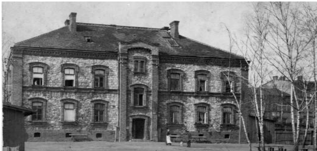
Fot.2. Dom nr 3 w domach fabrycznych „Częstochowianki”. Dziadkowie i rodzice mieszkali po prawej stronie na I piętrze w końcu lat 80. XIX wieku, aż do 1946 roku. Obecny adres: ul. Bardowskiego 21c
