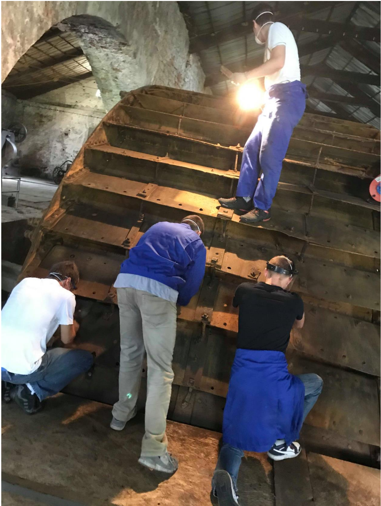
Rys. 3. Czyszczenie karczówek
