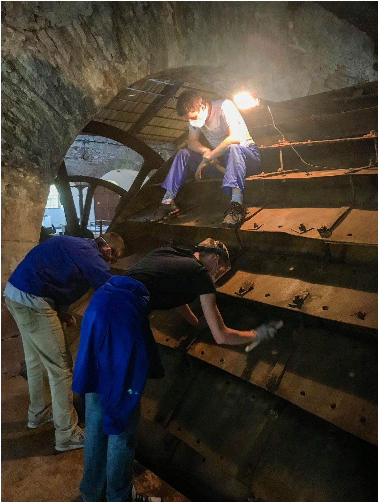
Rys. 2. Czyszczenie karczówek
