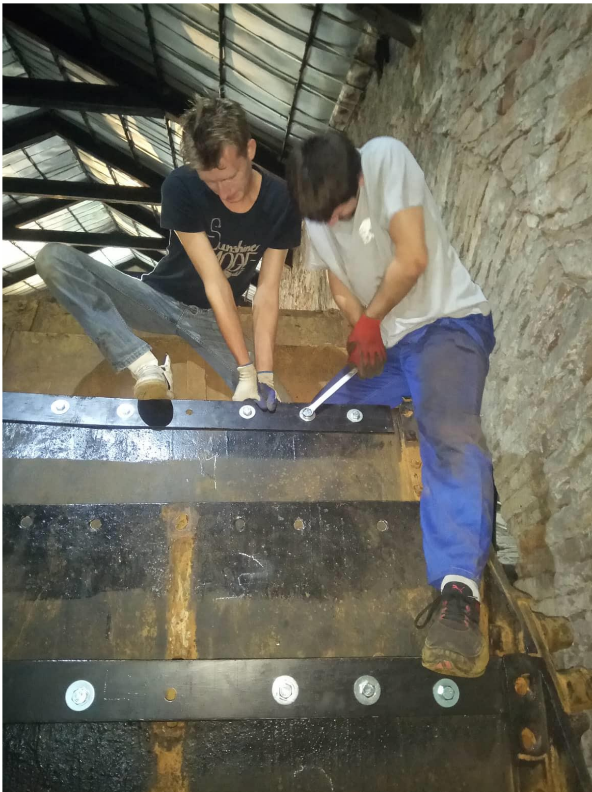
Rys. 4. Prace montażowe listew i połączeń śrubowych
