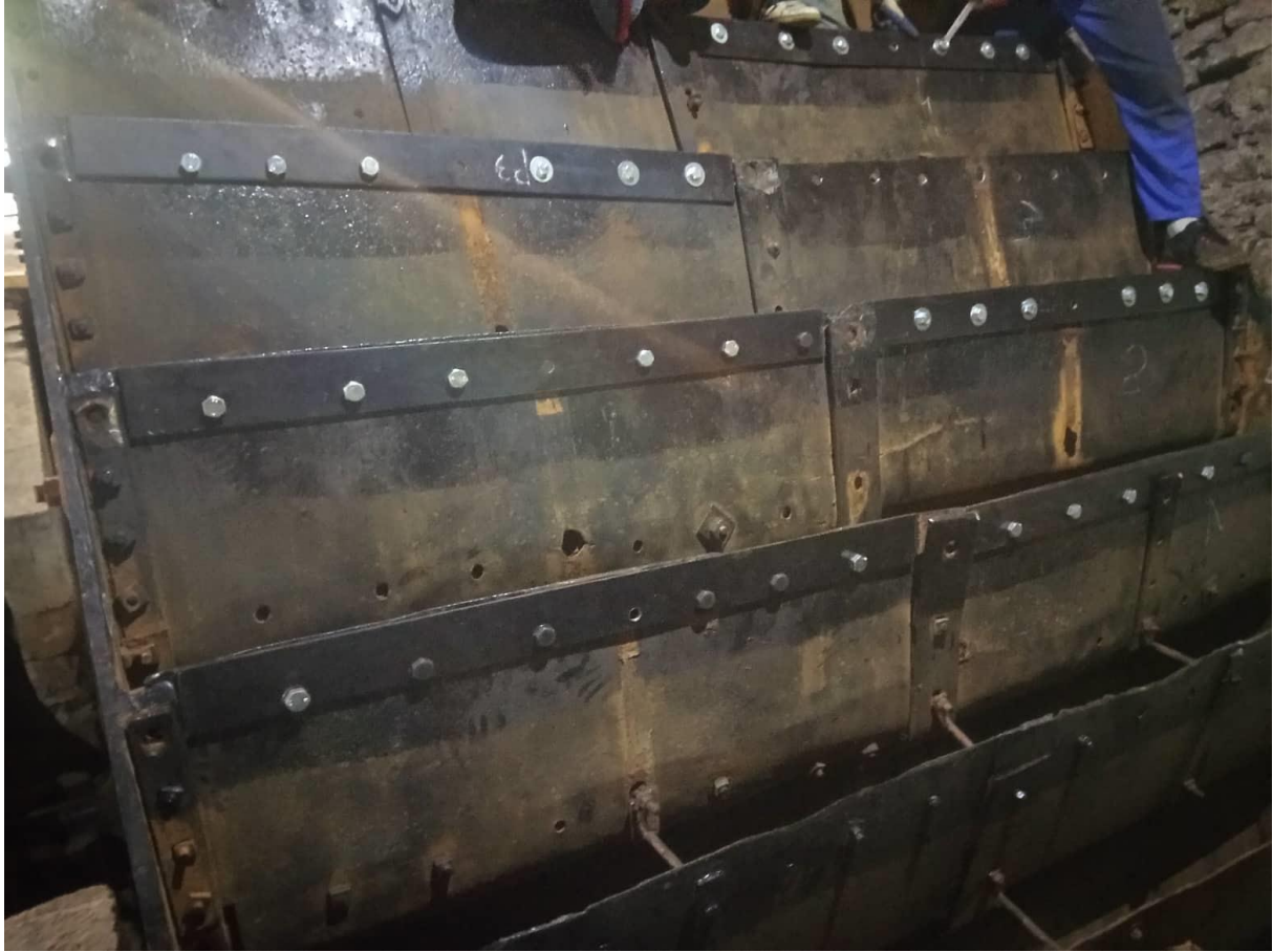
Rys. 5. Widok koła z częściowo zamontowanymi listwami i śrubami
