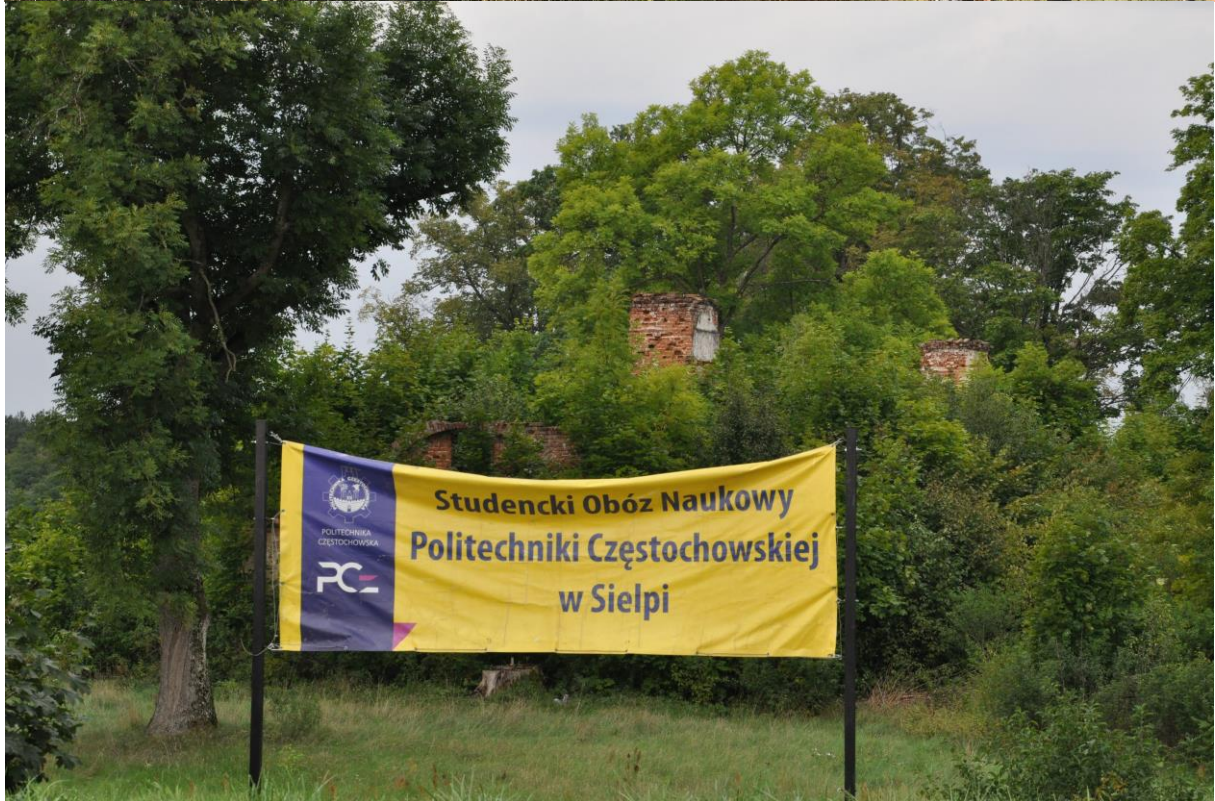
Rys. 22. Widok baneru pod koniec remontu
