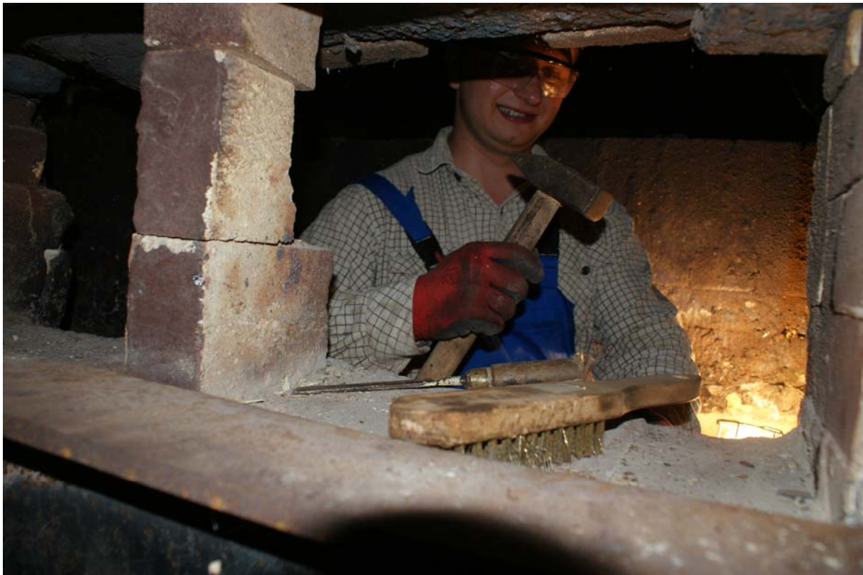
Rys. 7. Czyszczenie komory paleniskowej
