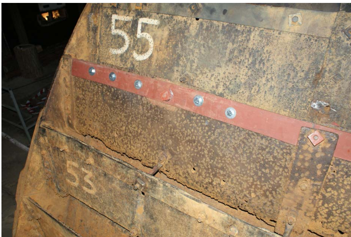
Rys. 3. Widok listwy mocującej karczówki nr 54 po montażu
