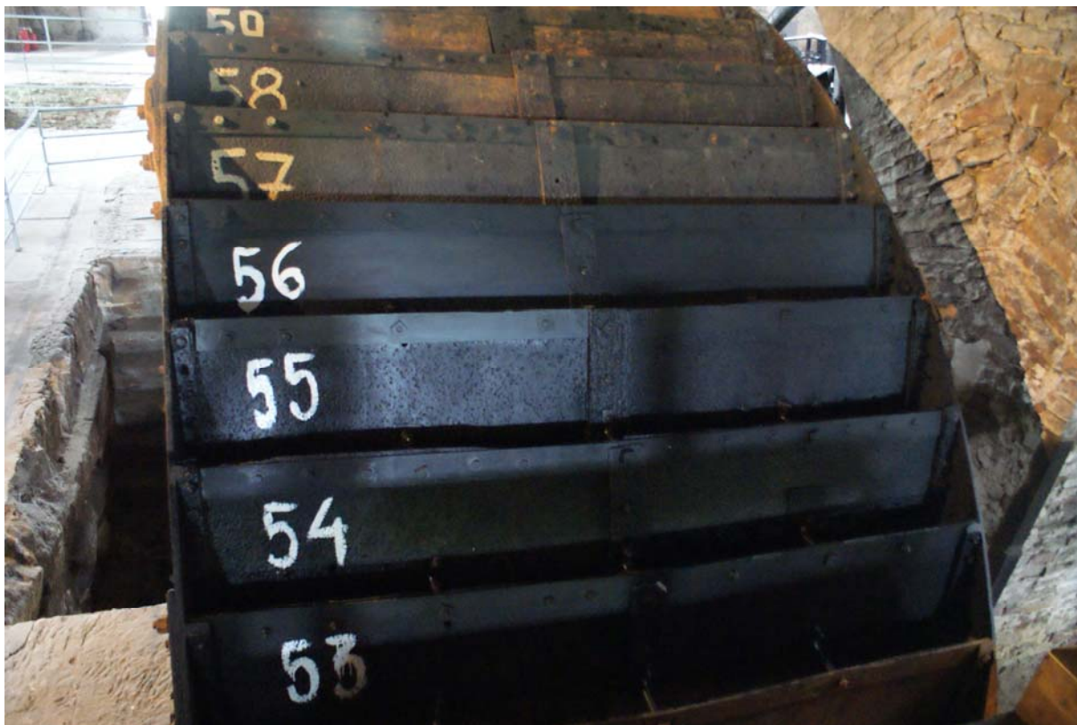
Rys. 4. Widok karczówek nr 53, 54 i 55 po zakończeniu prac i naniesieniu numerów
