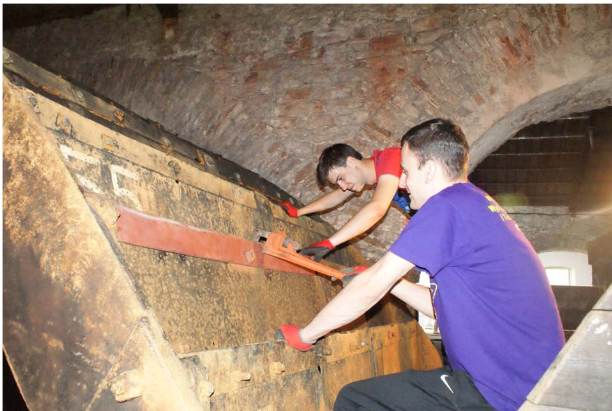
Rys. 2. Widok listwy mocującej karczówki nr 54 w trakcie przygotowania do montażu
