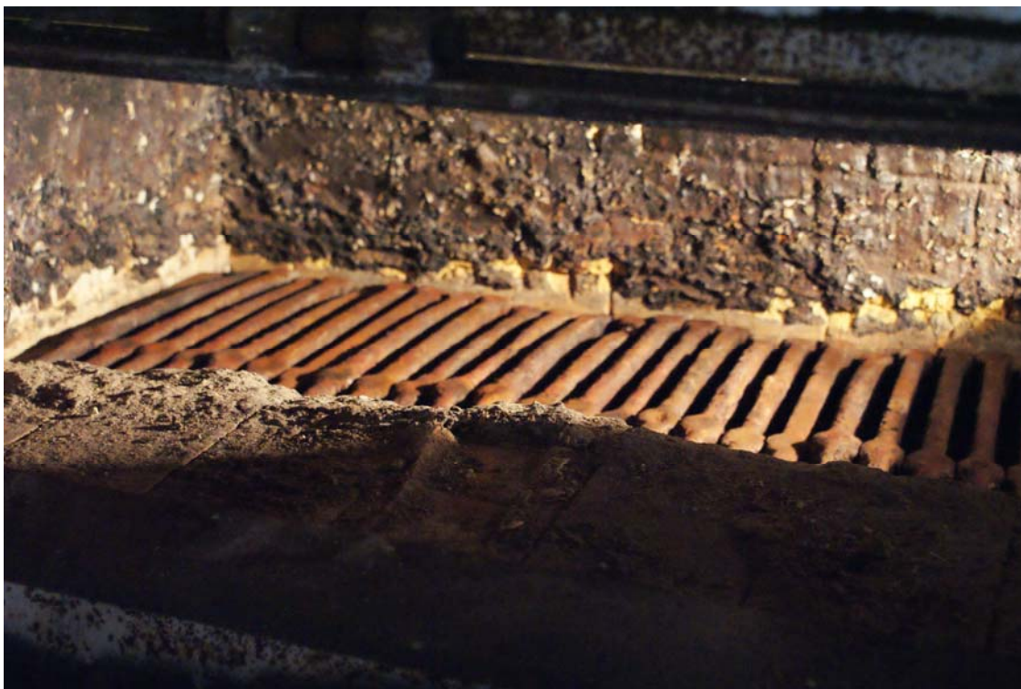
Rys. 8. Widok komory paleniskowej i rusztu po remoncie
