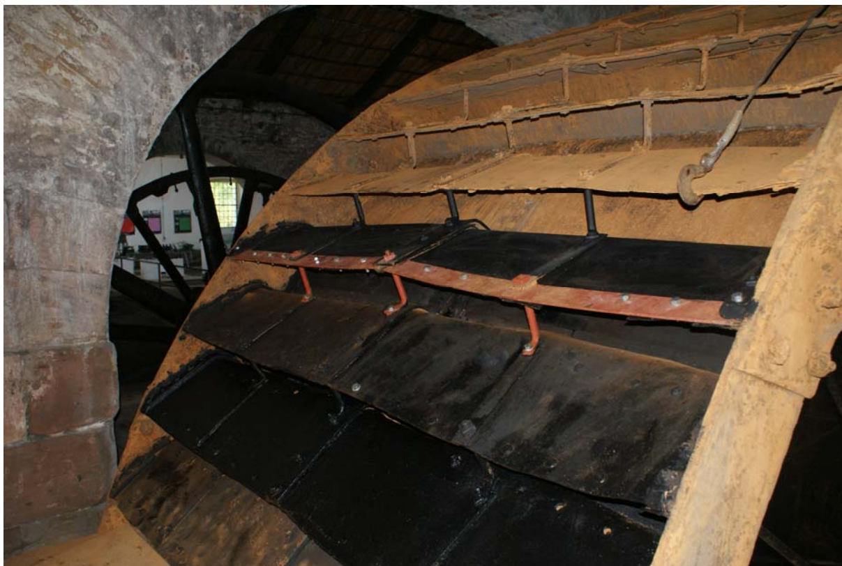
Rys. 4. Widok zakonserwowanych karczówek nr 33, 34 i 35 z widoczną wymienioną listwą mocującą
