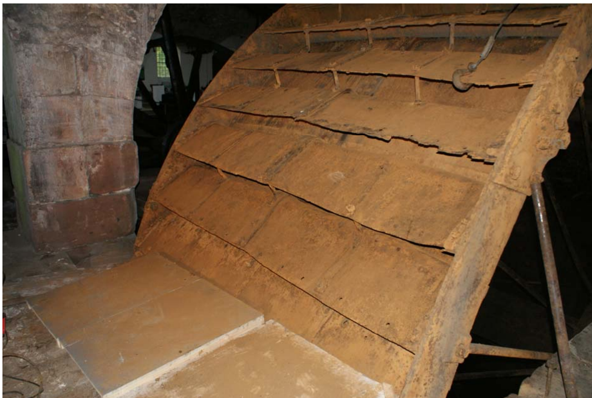
Rys. 1. Widok karczówek nr 33, 34 i 35 przed remontem i konserwacją
