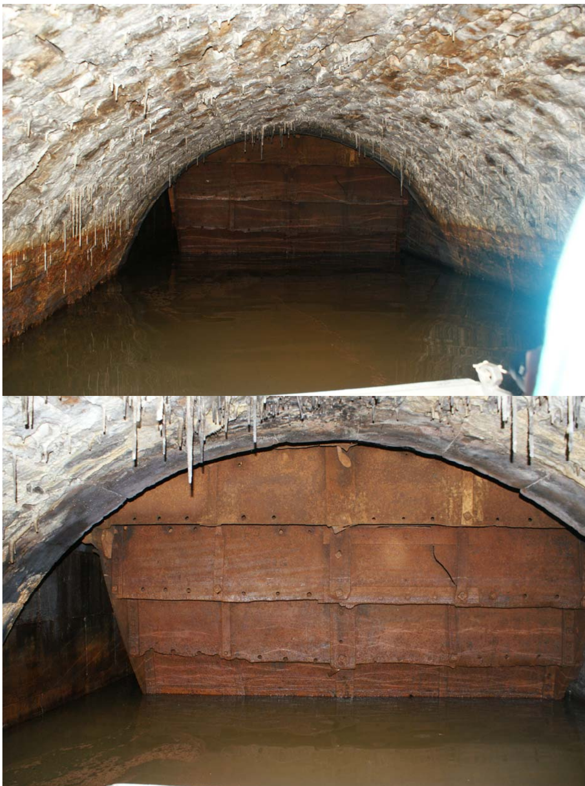
Rys. 9. Widok koła wodnego z perspektywy kanału podziemnego
