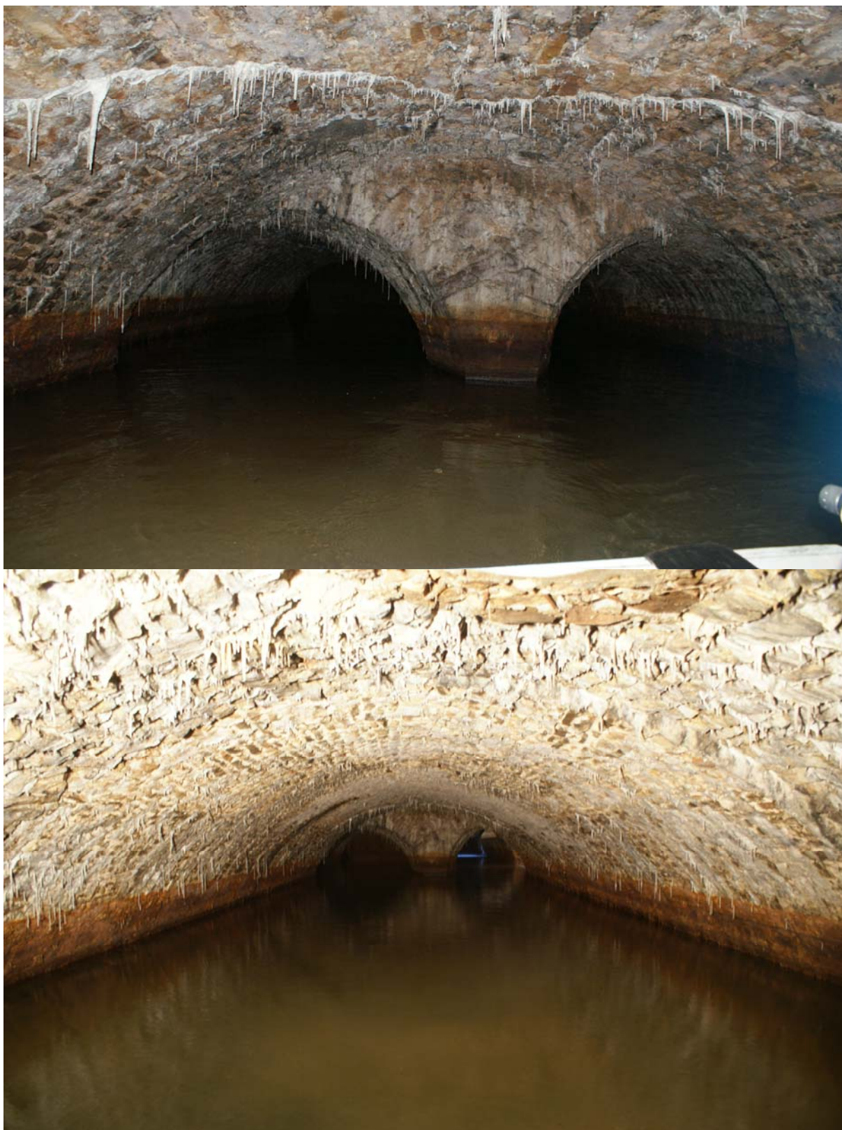
Rys. 8. Widok kanału podziemnego w kierunku koła wodnego
