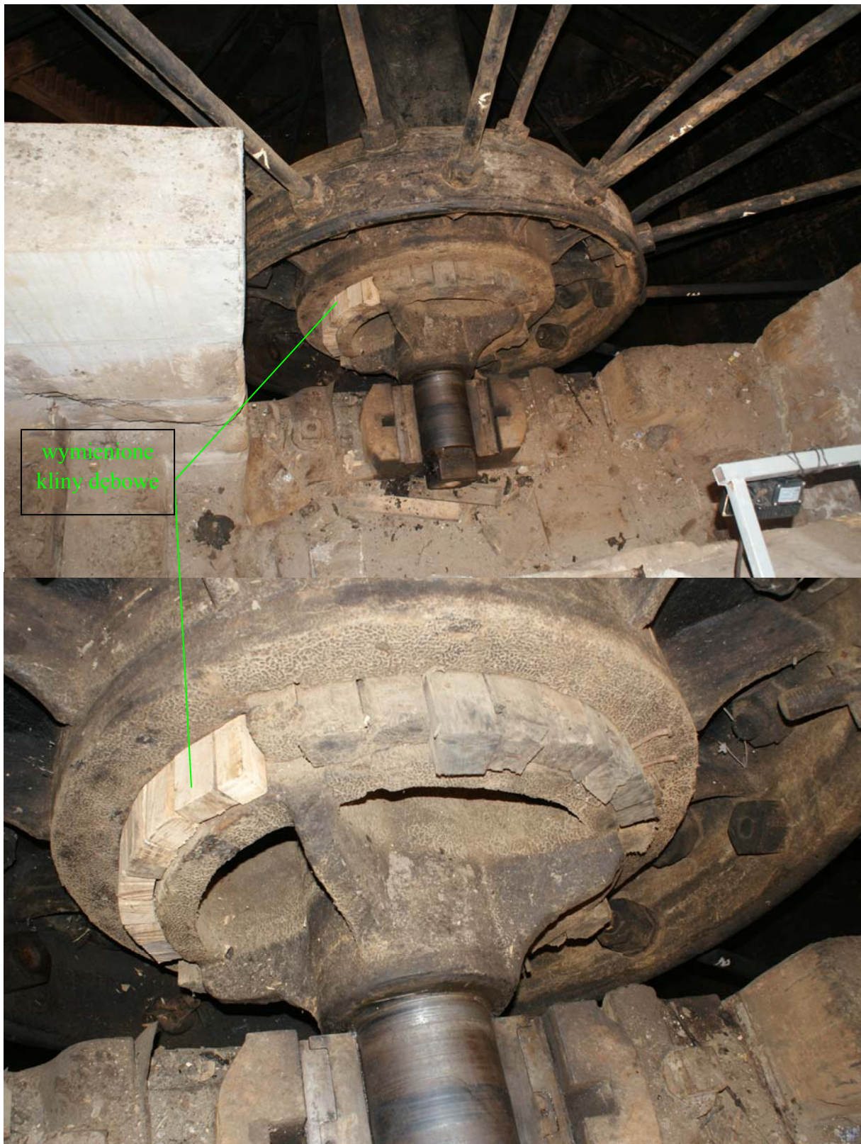
Rys. 6. Widok wału koła wodnego z uzupełnionymi klinami dębowymi
