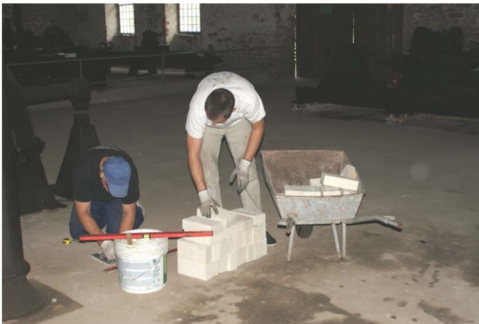
Rys. 16. Wymiarowanie miejsca pod postument wiertarki
