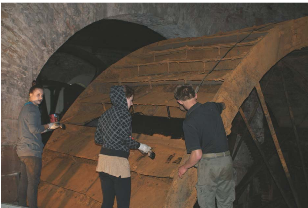
Rys. 3. Konserwacja karczówek nr 33, 34 i 35
