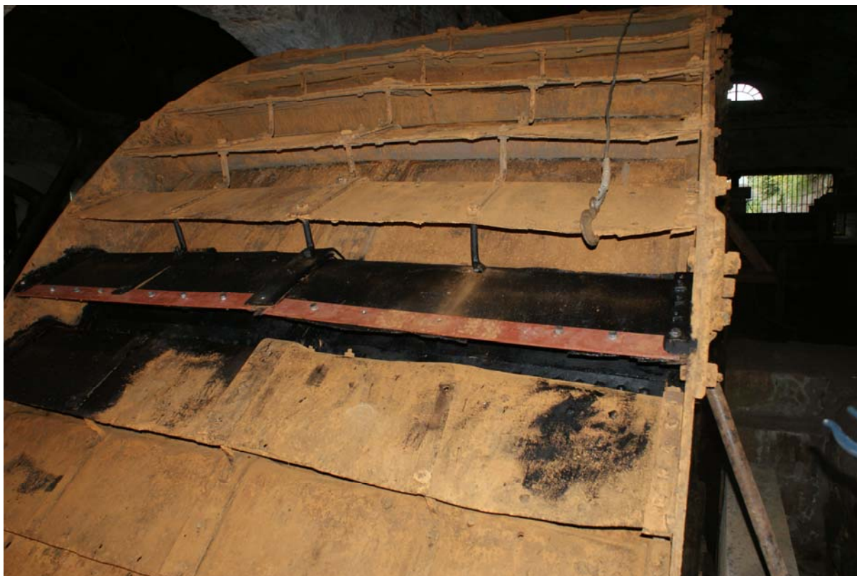
Rys. 2. Widok listwy mocującej karczówki nr 33 po wymianie
