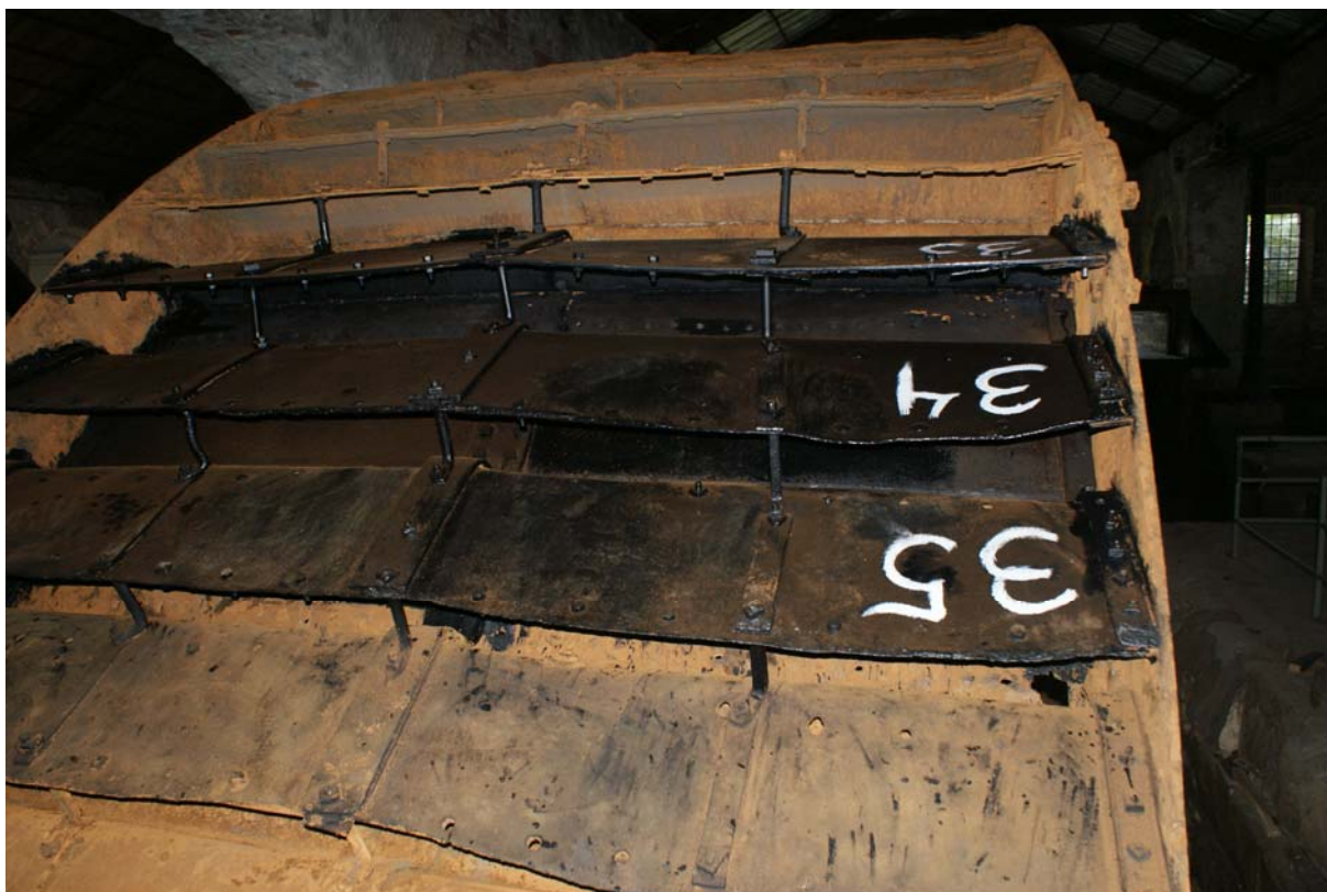
Rys. 5. Widok karczówek nr 33, 34 i 35 po zakończeniu prac i naniesieniu numerów
