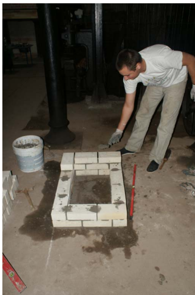
Rys. 17. Początki prac murarskich
