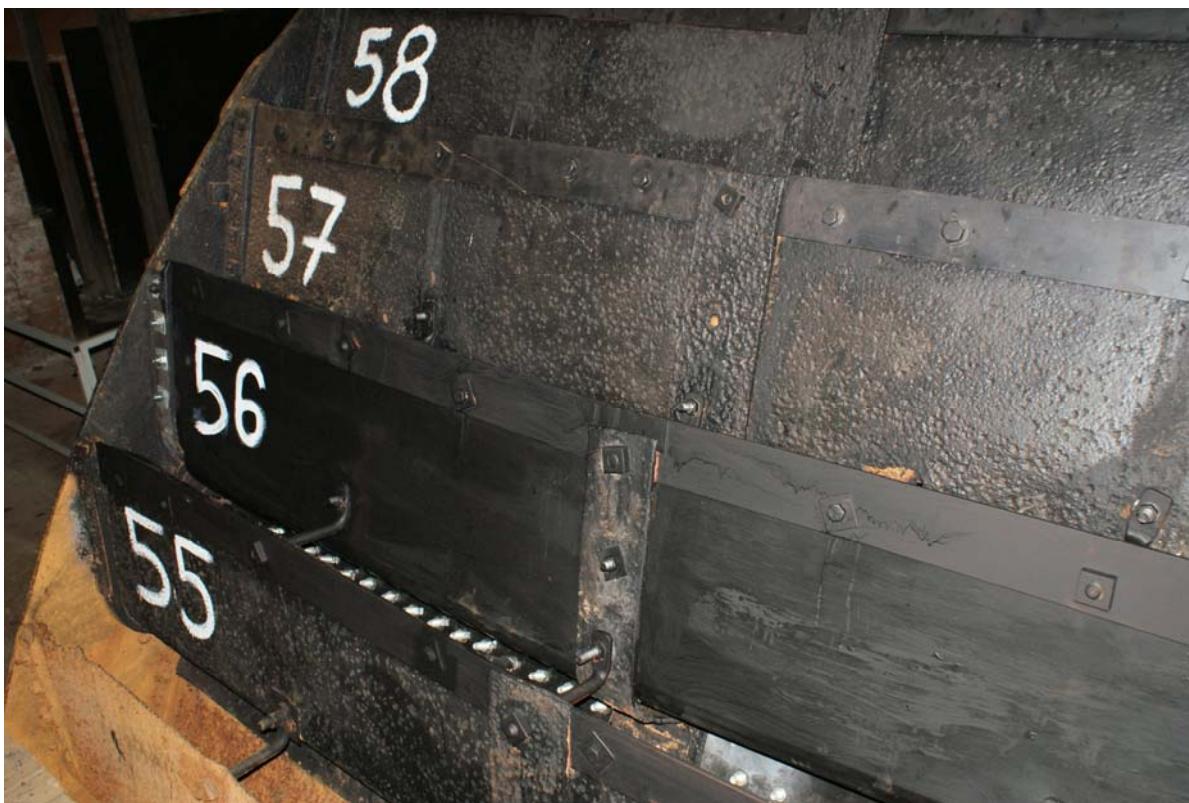
Rys. 3. Widok karczówek nr 55 i 56 po zakończeniu prac
