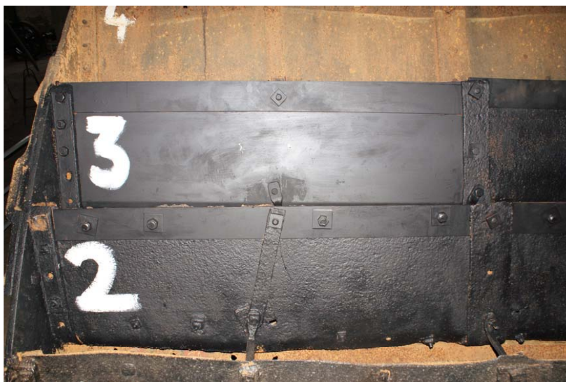
Widok karczówek nr 2 i 3 po zakończeniu prac
