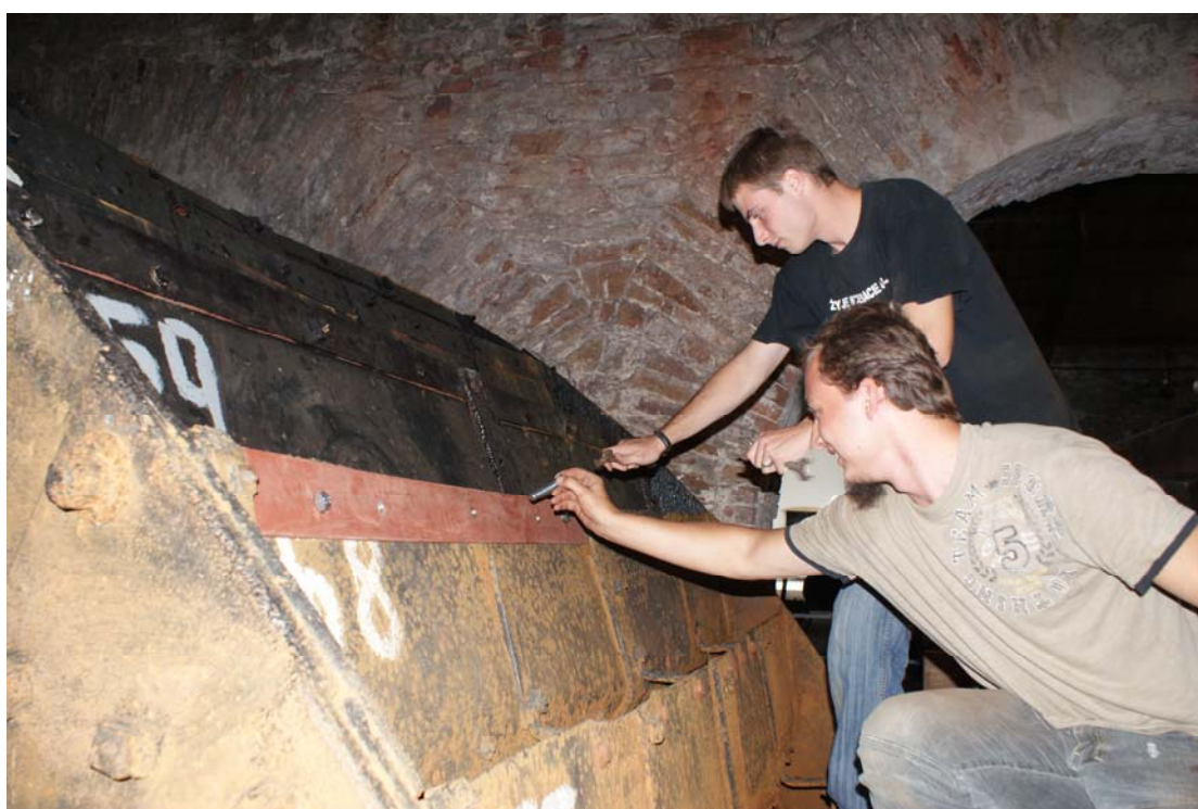
Montaż listwy mocującej na karczówce nr 58
