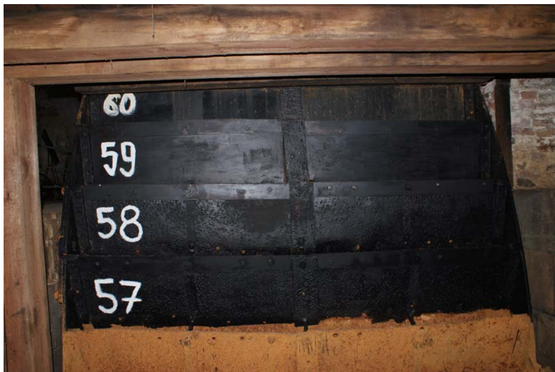
Widok karczówek nr 57 i 58 po zakończeniu prac
