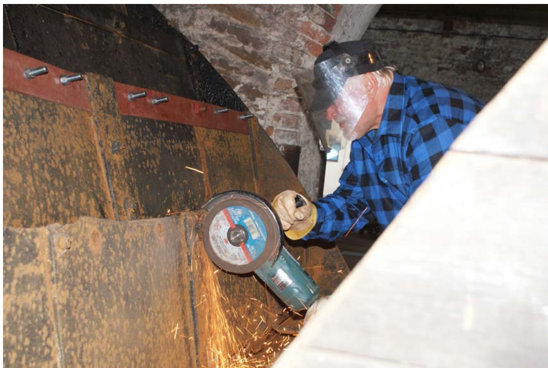
Demontaż karczówki nr 57
