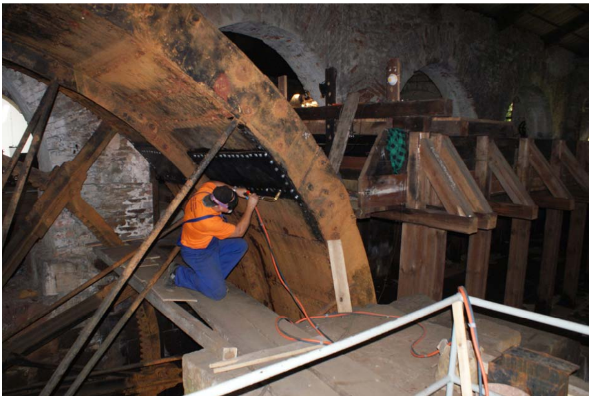
Prace montażowe na kole wodnym
