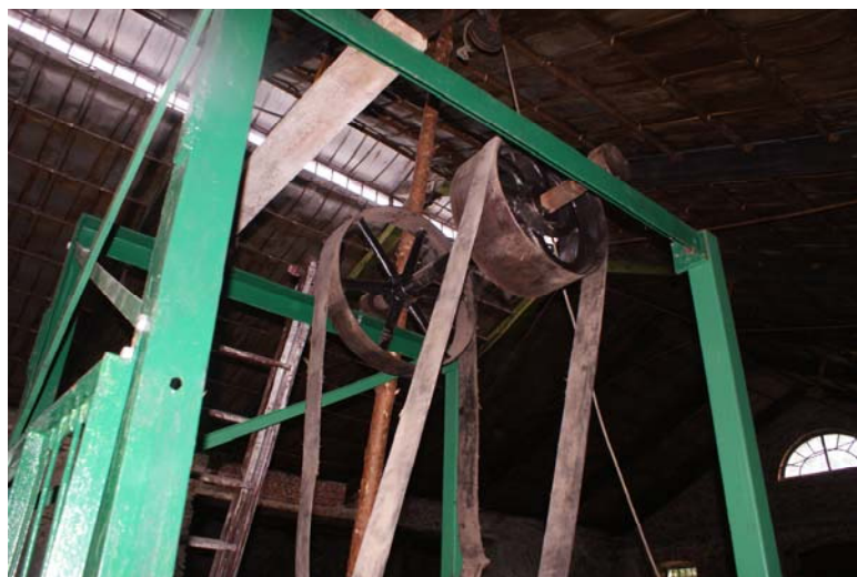
Umieszczenie kół pasowych na konstrukcji klatki i zamontowanie pasów
