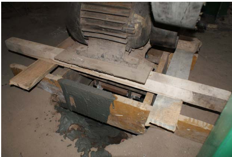
Przygotowanie konstrukcji pod zalanie fundamentu silnika
