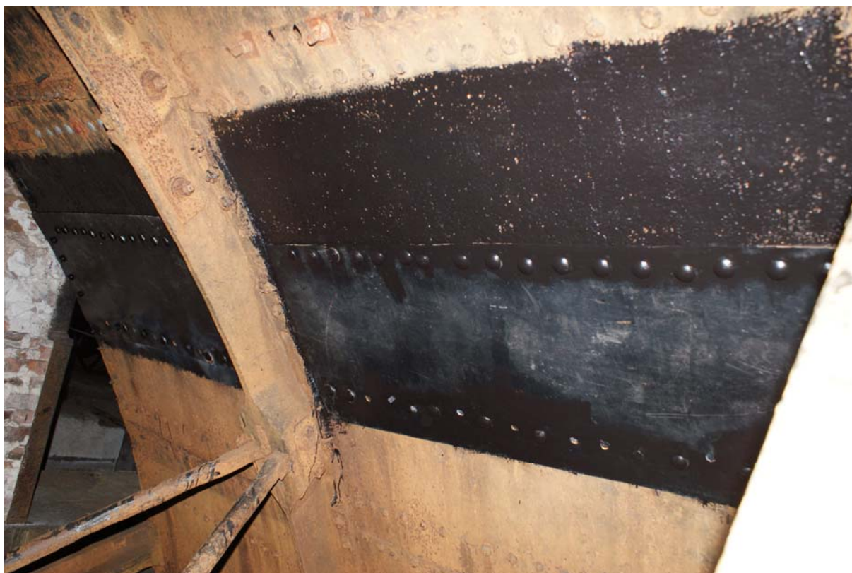
Wygląd fragmentu koła wodnego po zakończeniu prac remontowo-konserwacyjnych
